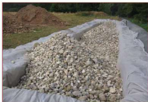
Mise en place du géotextile
